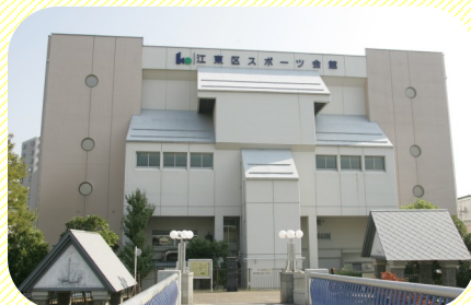
小名木川と横十間川が交差するクローバー橋のたもとにあります。
